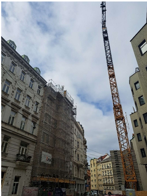
Sanierung in der Ungargasse
